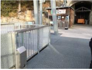
Ein- und Ausstiegsbereich Bergstation
