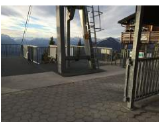
Ein- und Ausstiegsbereich Bergstation
