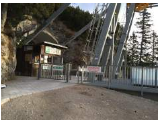
Ein- und Ausgang Bergstation
