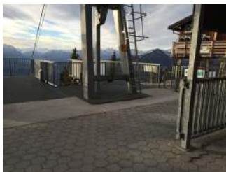
Weg Seilbahn Bergstation und Ein- und Ausgang
