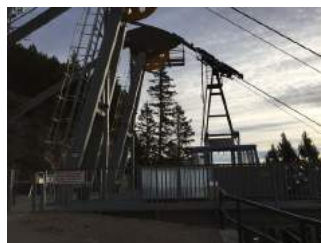
Ein- und Ausstiegsbereich Bergstation
