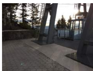
Ein- und Ausstiegsbereich Bergstation
