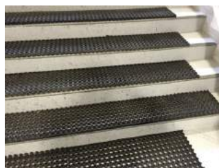
Treppe auf dem Weg zur Bahn
