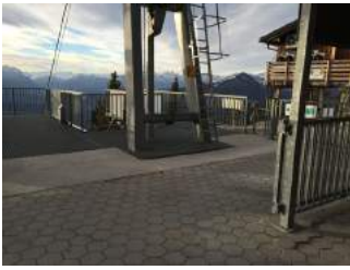
Ein- und Ausstiegsbereich Bergstation
