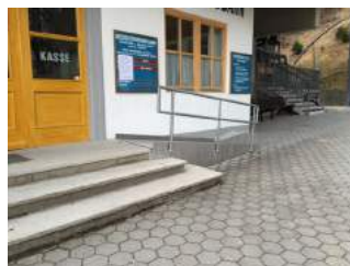
Rampe und Treppe
