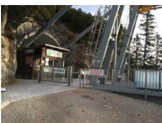
Ein- und Ausgang Bergstation
