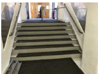
Treppe auf dem Weg zur Bahn
