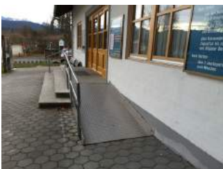
Rampe zum Eingang
