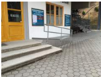
Treppe und Rampe zum Eingang
