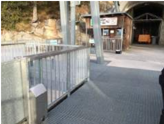
Ein- und Ausstiegsbereich Bergstation
