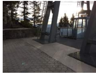
Ein- und Ausstiegsbereich Bergstation
