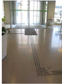
Leitstreifen in Lobby
