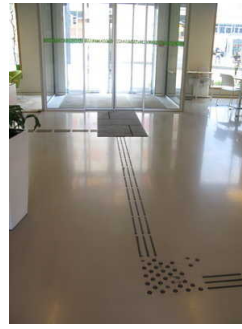
Haupteingang mit taktilem Leistsystem
